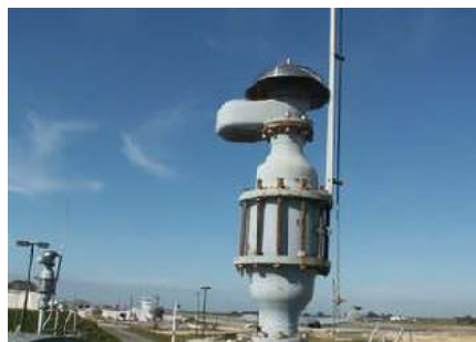
写真1. プロテゴ型はブリーザーバルブとフレイムアレスターの一体型がありますので、ブリーザーバルブとフレイムアレスターの組み合わせで実証試験をされていない場合は写真2の一体型VD/TSをご使用ください。
