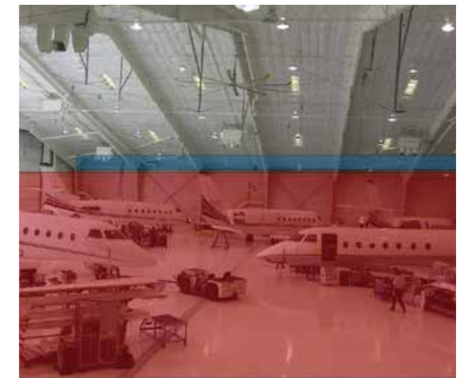
写真2. 防護/非防護エリアの設定。 赤い部分は非防護エリアで青い部分は防護エリアとなっているため、天井付近に到達した火災や煙のみを感知することが可能です。
